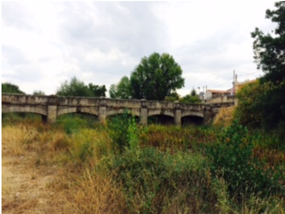
Puente de entrada en Bocacara
