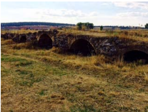
Puente de Calzadilla de Valmuza
